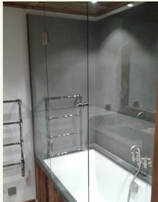
Pare-douche posé chez un particulier
